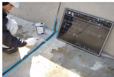
写真 5.1-4 プライマー塗布
