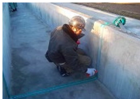
写真 5.1-6 シーリング材押さえ
