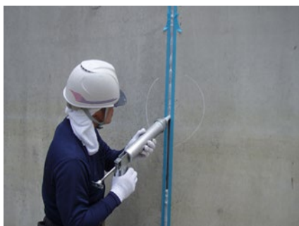
写真 5.1-5 充填機による作業
