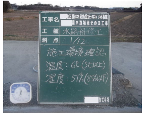
写真 5.1-1 表面の乾燥状況の確認
