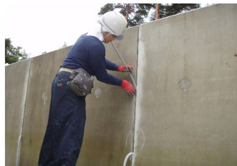
写真 5.1-2 バックアップ材の取り付け作業
