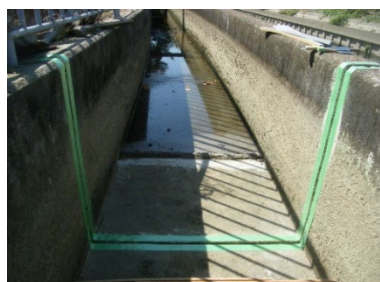
写真 5.1-3 充填箇所の養生
