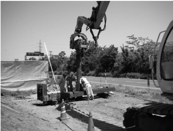
図-7 鋼矢板打ち込み状況
