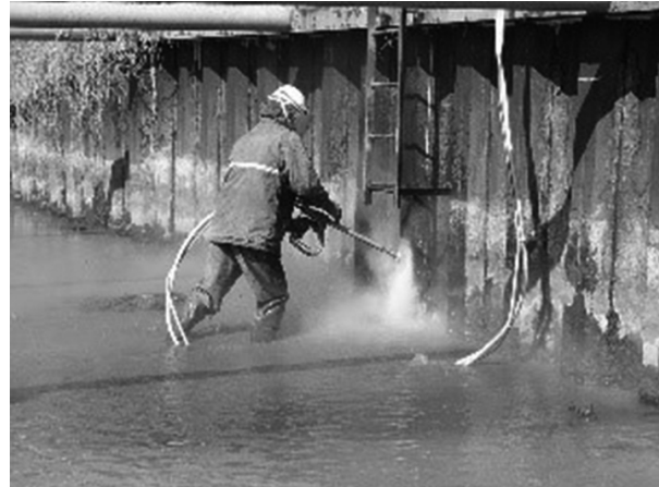
図-13 超高压ウォータージェット状況
