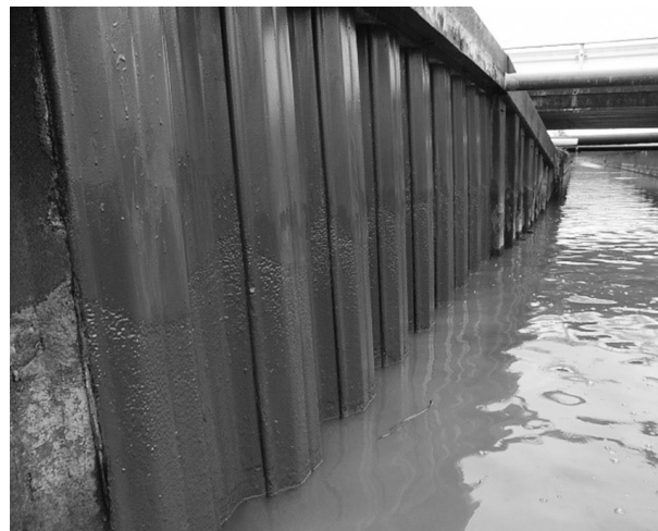
図-2 ラスタップ工法施工後
