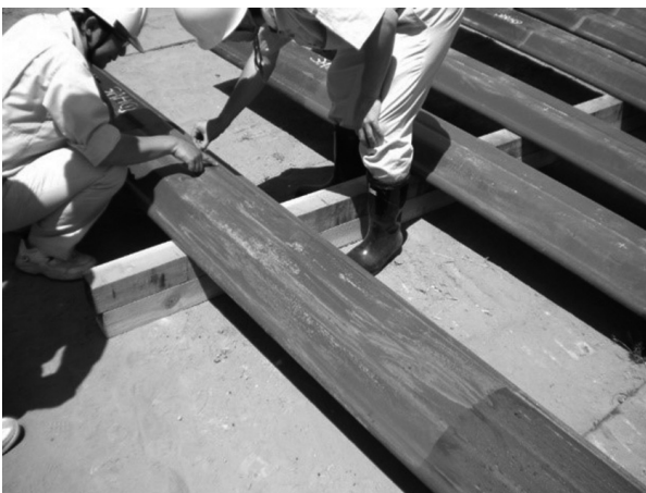
図-8 鋼矢板打ち込み後の塗膜確認
