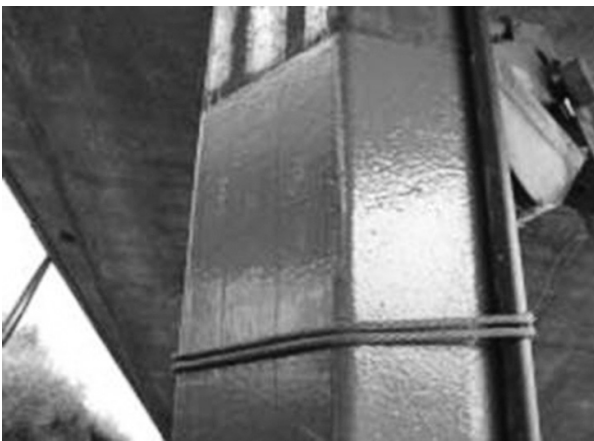
図-9 鋼矢板塗装後にワイヤーロープで移動でも塗膜剥離無し
