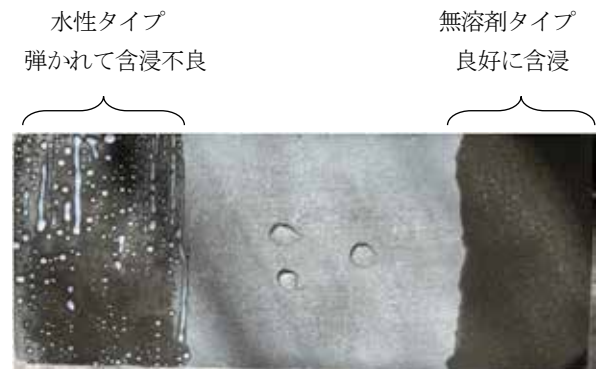
図－5 再補修直後の外観
