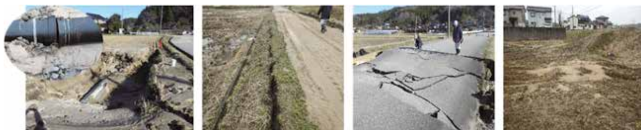
写真-1 左から「継手の離脱」、農地や道路の「地割れ」、「沈下」、「噴砂」
