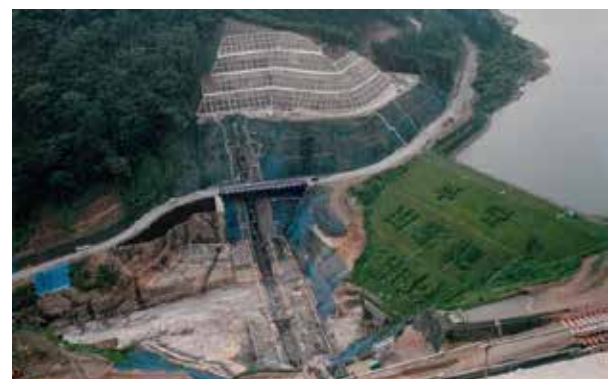
写真－7 建設中の新山王海ダム （旧山王海ダムの堤体を取り込んで建設）
