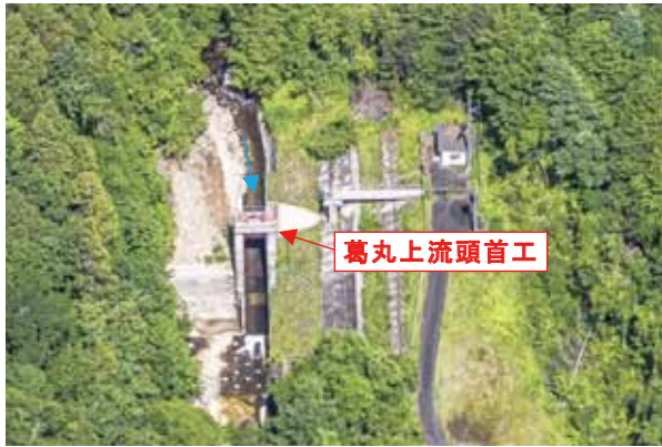
写真－12 山あいにある葛丸上流頭首工 (葛丸ダムへの洪水流入制御の要となる施設)
