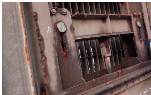
写真－11 老朽化が顕著なゲート設備 (山王海ダム取水設備)
