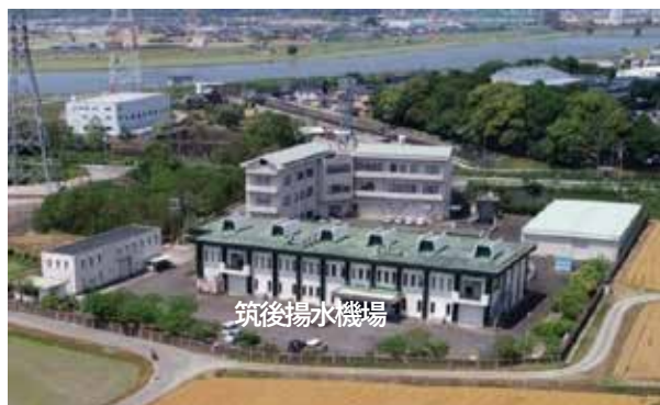
写真－1 筑後揚水機場
