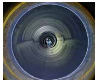
写真-6 PIP 施工完了状況
