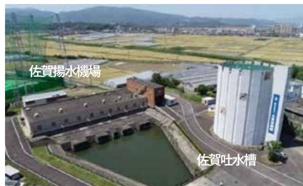
写真－2 佐賀揚水機場
