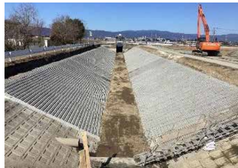
写真-9 法面整備工事完成
