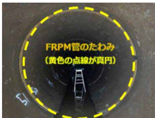
図-7 FRPM 管のたわみの状況
