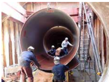
写真-5 巻込鋼管挿入状況
