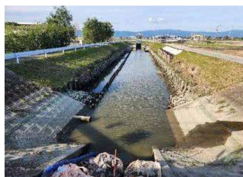
写真-8 施工前の状況
