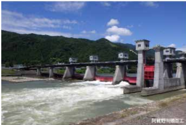
写真－１ 阿賀野川頭首工全景
