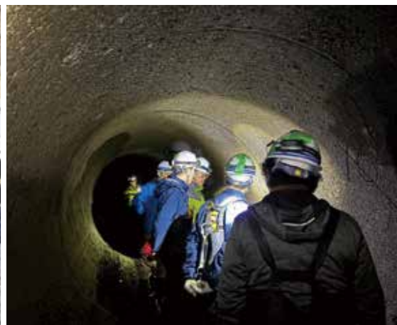
(調査の状況(管水路内))
