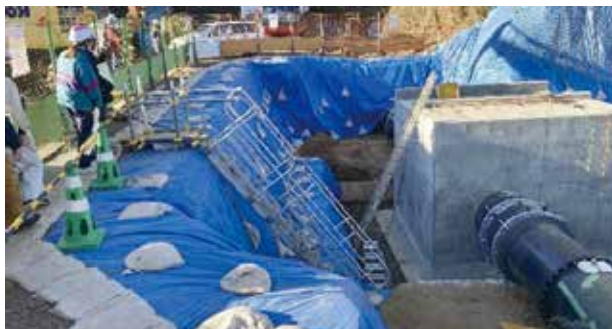
(十余三工区工事(制水弁新設)の状況)
