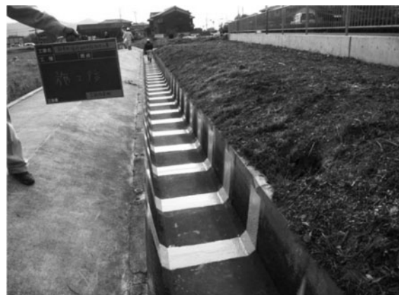
図-7 開水路目地補修
