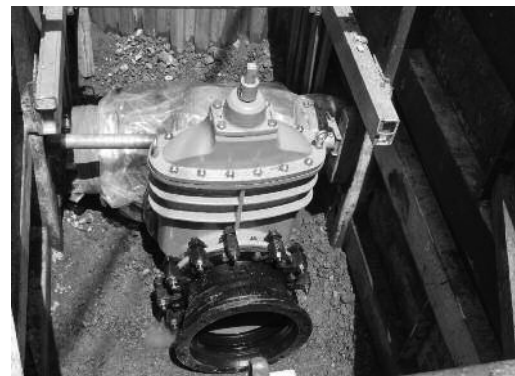
写真-5 補強金具設置状況 (一般フランジ用) 呼び径 400mm
