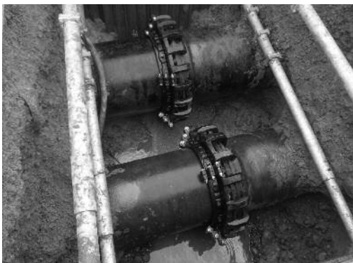
写真-4 補強金具設置状況 (A・K形用) 呼び径 700mm, 800mm
