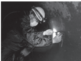
写真-2 たわみ計測状況
