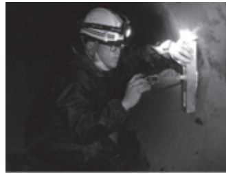
写真-3 ひずみ計測状況
