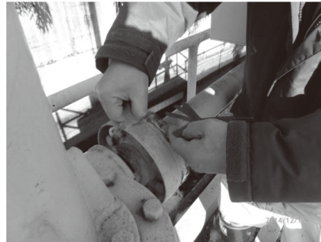
写真-2 軸継手の芯ずれ測定状況
