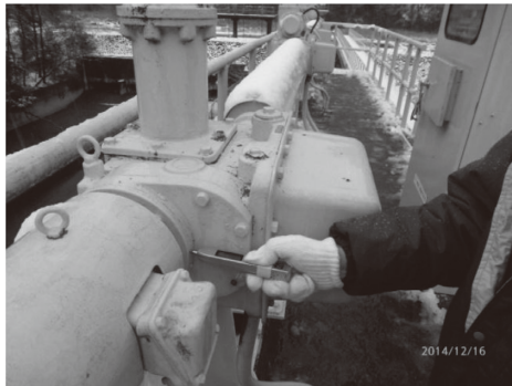
写真-1 開閉機の振動測定状況
