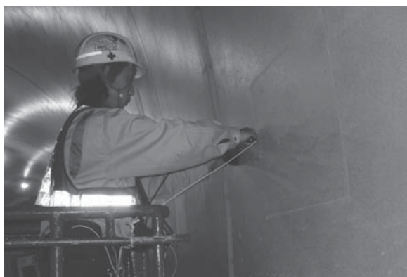
写真-3 調査状況
