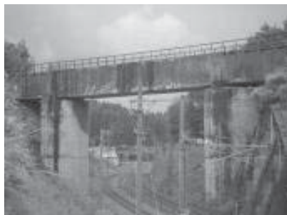
写真-2 IGR 水路橋正面
