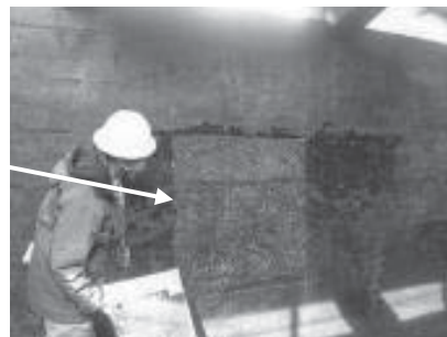
写真-4 高圧洗浄による状態確認
