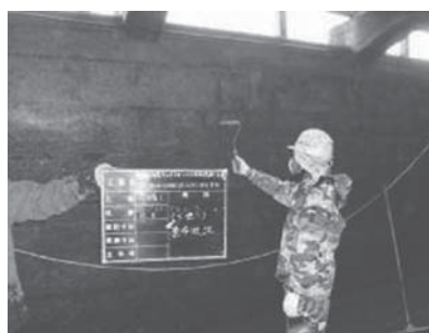
写真-15 含浸工法 ローラ施工
