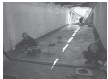
写真-10 ポリマーセメント系施工コテ仕上げ
