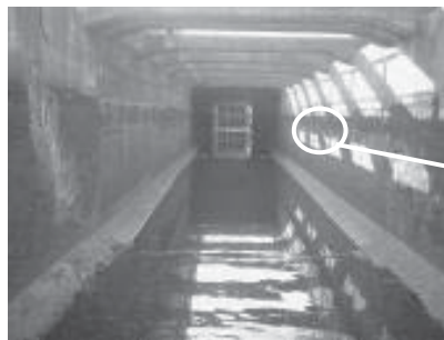
写真-3 IGR 水路橋内面
