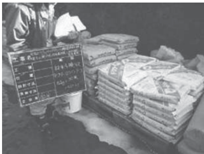
写真-8 材料検査
