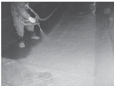
写真-11 樹脂系施工 吹付け
