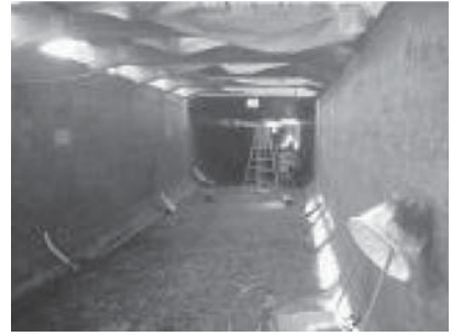
写真-7 底板・側壁高圧洗浄後
