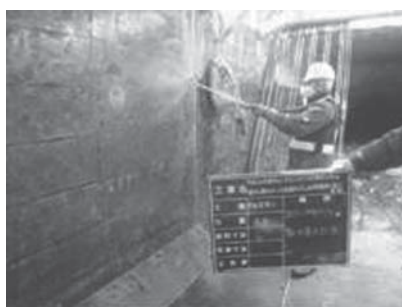
写真-14 含浸工法 吹付け
