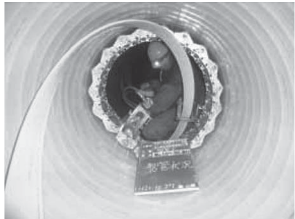
④管水路の更生工法による補修
