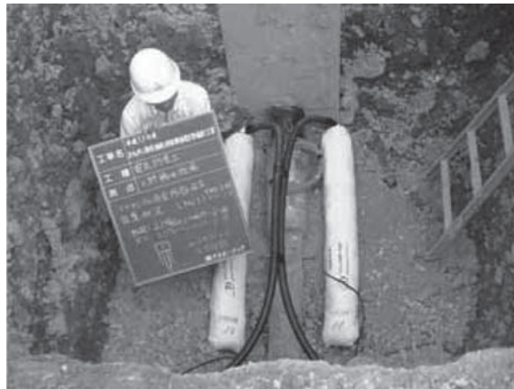
図－8 電気防食（流電陽極設置）
