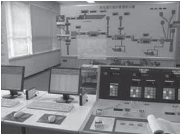
①水管理制御設備の補修・更新
