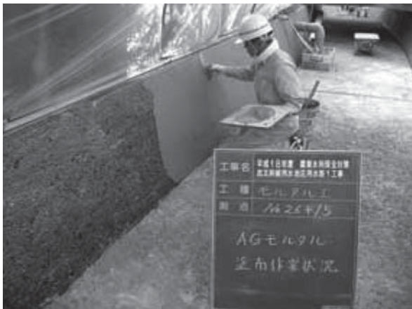
③開水路のライニングによる補修
