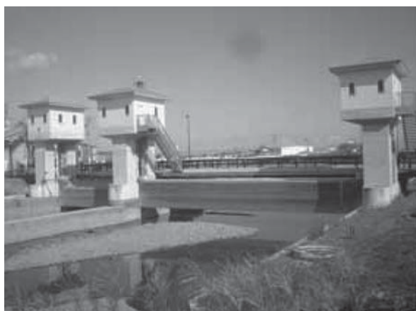
大井川用水（栃山頭首工）
