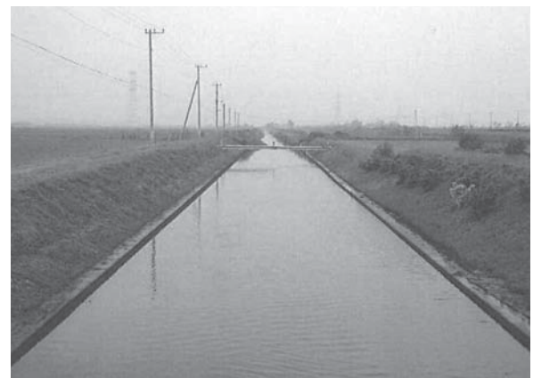
図-4 水位を下げるのが困難で、通年にわたり笠コンクリート部しか目視出来ない鋼矢板排水路
