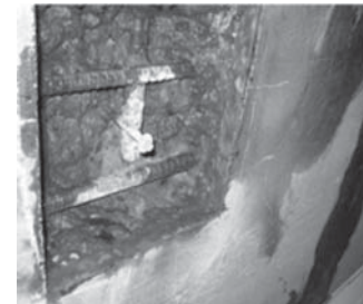
写真-4 鉄筋の状況
