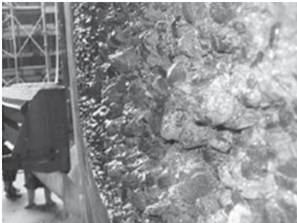
写真-9 ウォータージェットによるハツリ面
