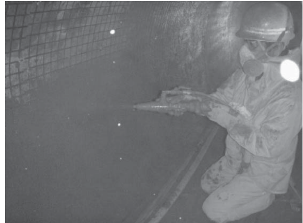
写真-4 FRP グリッド補強内巻工法 (施工状況 2)
