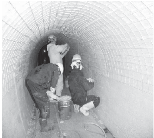
写真-2 鉄筋補強内巻工法 (施工状況2)
