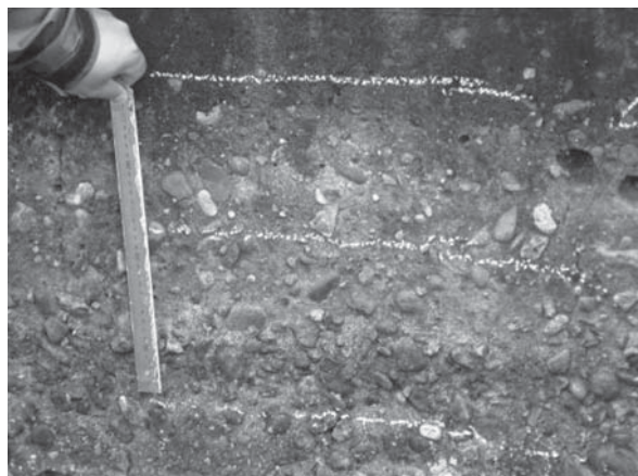
用水路側壁 (茨城県)
