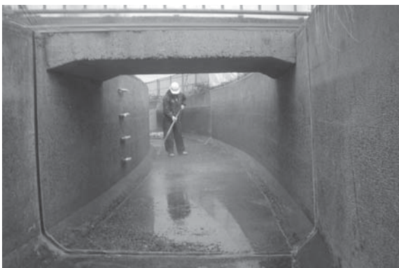
(10) 側壁施工 モルタル吹き付け
