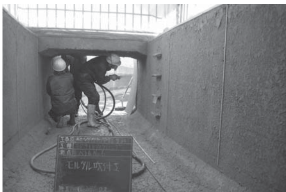
(10) 側壁施工 モルタル吹き付け
