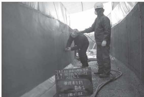
被膜養生剤散布
