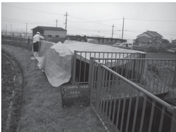
(1) 下地処理飛散養生工
