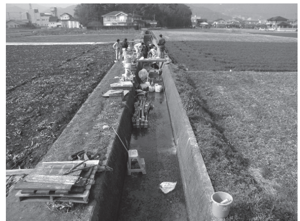
図1 土器川沿岸地区における試験施工 2002（平成 14）年 3月
