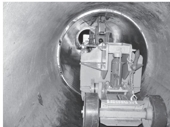
写真1 無軌道台車と管の搬入状況
