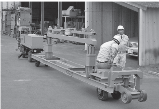
写真1 無軌道台車と管の搬入状況
