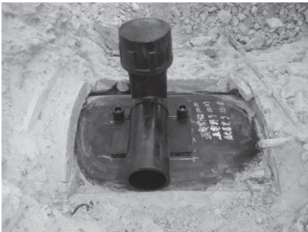
写真7 専用継手による分岐部の形成
