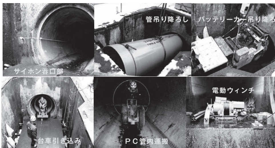
写真-1 リフトイン工法の工事状況
