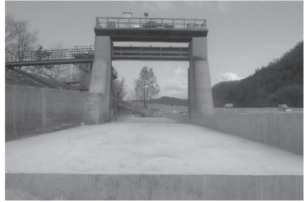
写真-4 土砂吐下流部 （コンクリート打増による補修後）
