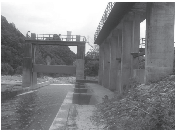
写真-9 土砂吐上流部（補修後）
