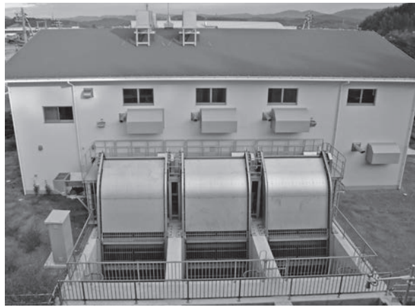
写真 14 名草排水機場 (2022年完成:和歌山市)
