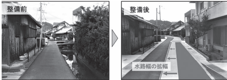
写真9 水路断面を拡幅した安楽川井水路（C水路）（紀の川市）
