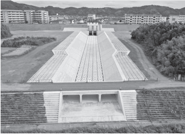
写真 12 千旦樋門・堤外千旦放水路(2022年完成:和歌山市)
