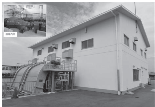
写真8 改修後の米田排水機場(和歌山市)
