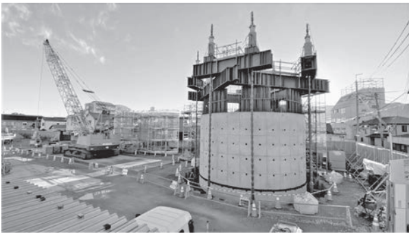
写真 13 立坑 (圧入オープンケーソン工法)
