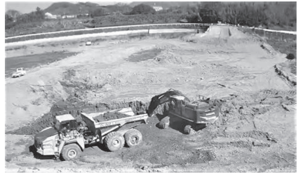
写真 18 大溜池改修工事 (堤体掘削) (2022 年着手)
