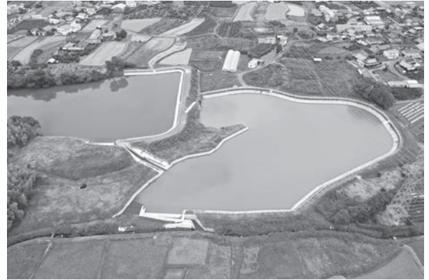
写真 17 左側：上ノ池改修工事 (2022 年完成) 右側：森の池改修工事 (2021 年完成)
