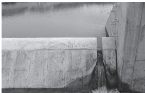
写真11 切り欠き設置（上ノ池）（紀の川市）
