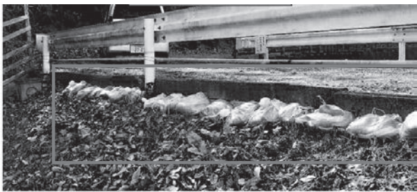
図-4 対策の措置状況（土のう設置）
