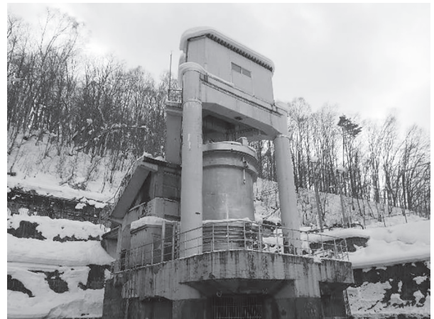
図-1.4 取水設備全景写真
