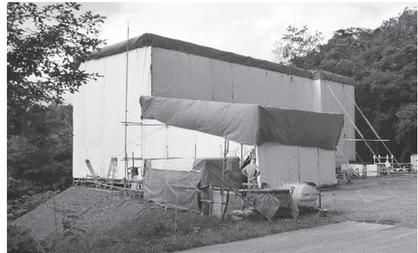
図-1.7 仮設工場設置状況
