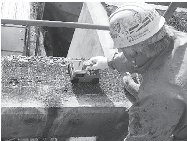
図-2.9 鉄筋探査状況
