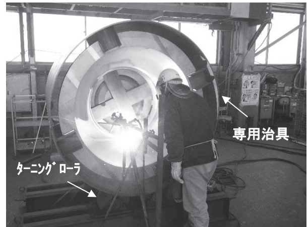
図-2.7 本体溶接状況
