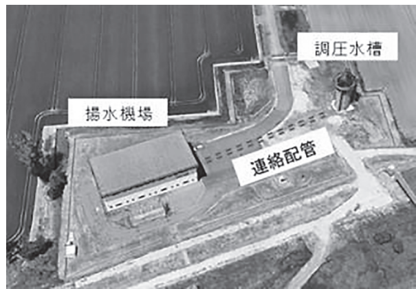
写真-1.3 八幡揚水機場外観
