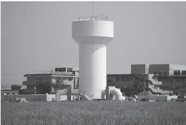
写真-1.1 調圧水槽外観
