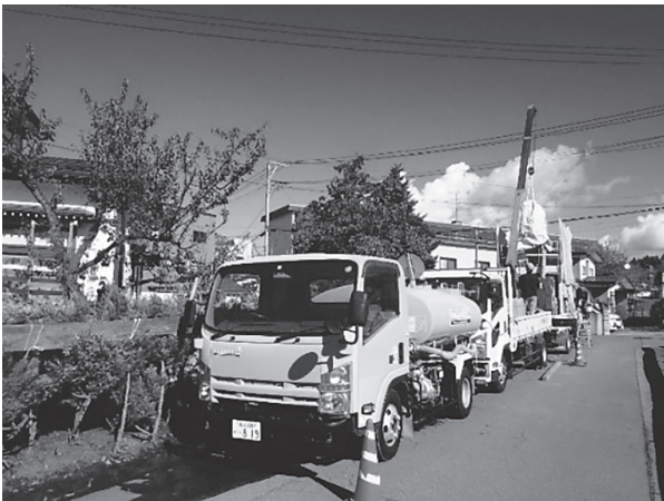
写真-6 裏込め材注入時の車上プラント
