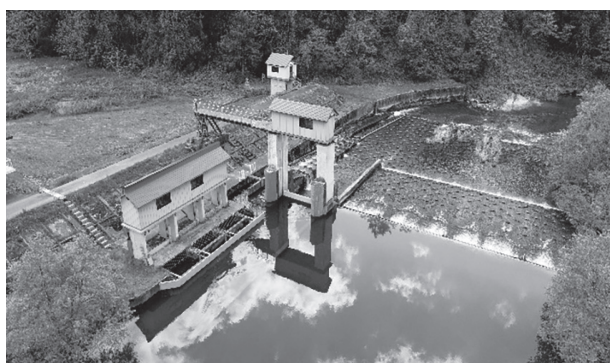
写真-3 新一の堰頭首工 (改修前)
