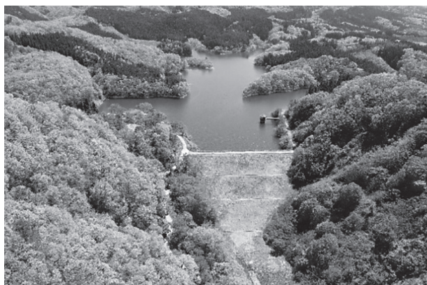
写真-1 あいののダム (改修前)
