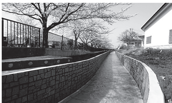
写真-4 旭川左岸幹線用水路 (改修後)
