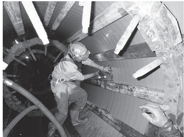
写真-7 打音確認の様子
