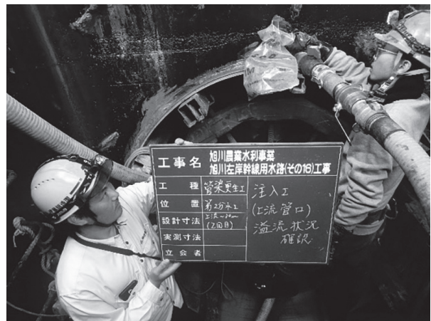
写真-8 上部管口からの溢流確認の様子
