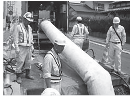
反転工法挿入状況 (マニュアル【パイプライン編】より)
