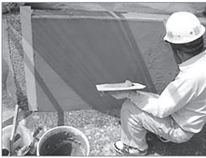
無機系被覆工法施工状況 (マニュアル【開水路補修編】より)
