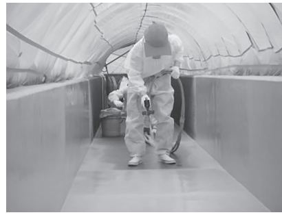
有機系被覆工法施工状況 (マニュアル【開水路補修編】より)
