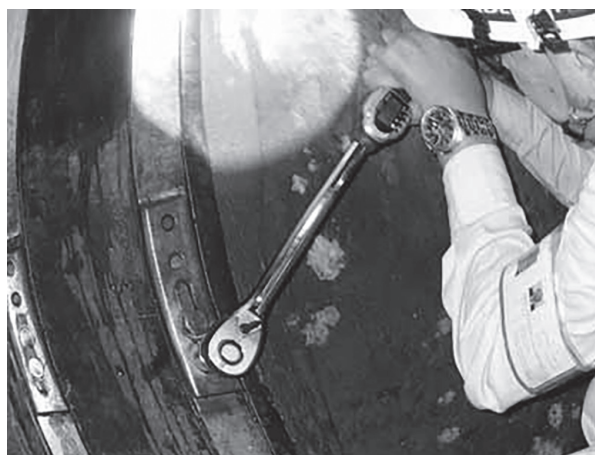
写真4 施工4年後の止水バンド固定ボルト締付圧力の計測状況
