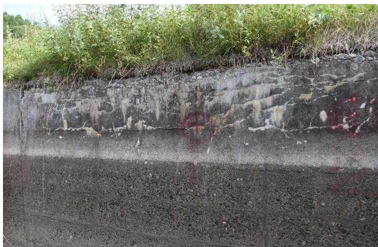
写真 A 幹線水路の状況
