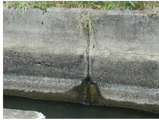
写真2 開水路目地部の状況
