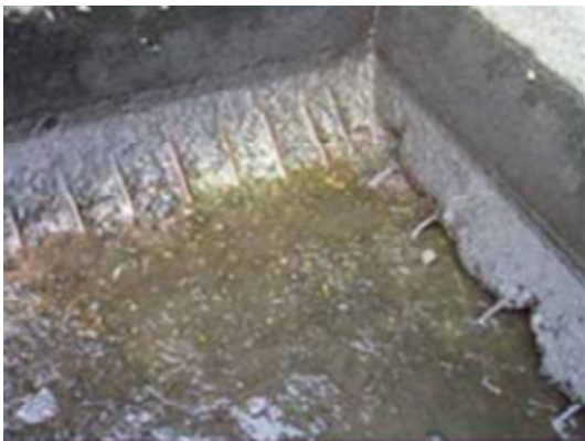
写真1 落差工の状況
