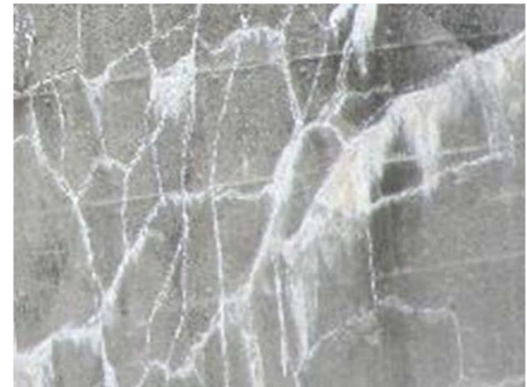
写真：A支線水路側壁のひび割れ発生状況
