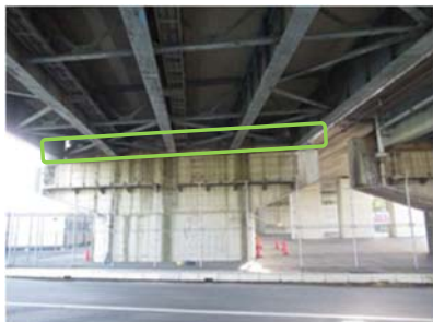
高速道路 橋梁RCパラペット
