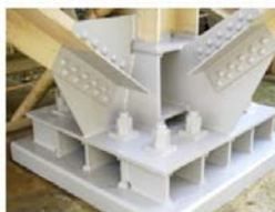
H鋼下部塗装
