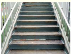
階段掘上がり部補修
