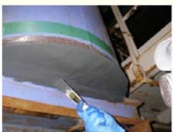
タンク下部補修
