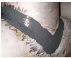
SUS溶接部補修
