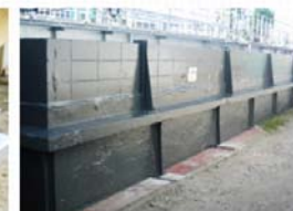
コンクリート防水
